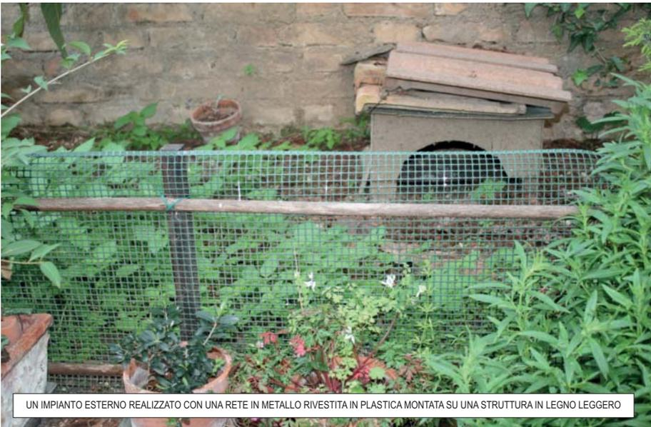
UN IMPIANTO ESTERNO REALIZZATO CON UNA RETE IN METALLO RIVESTITA IN PLASTICA MONTATA SU UNA STRUTTURA IN LEGNO LEGGERO
